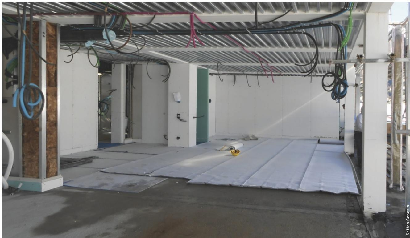
Fase di posa dell'impianto a pannelli radianti. Immagine delle spire radianti prima della posa del massetto
