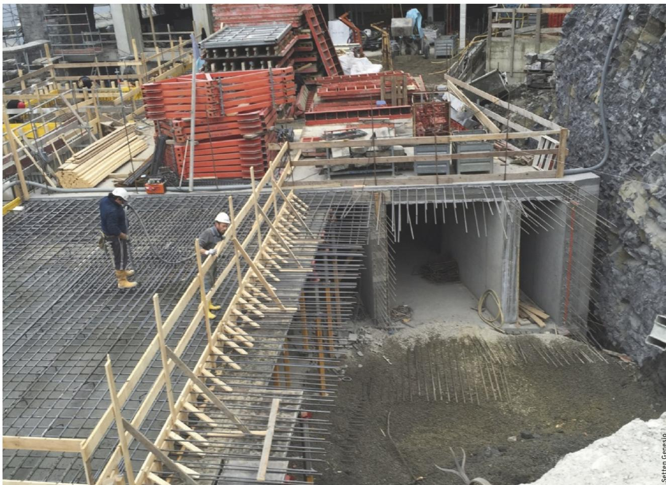
Armatura e getto dei solai di calcestruzzo armato del piano terra
